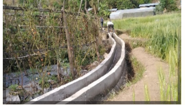
सिंचाई कुलो निर्माण बरपिपल कृषक समुह पञ्चपुरी २ जंगला
