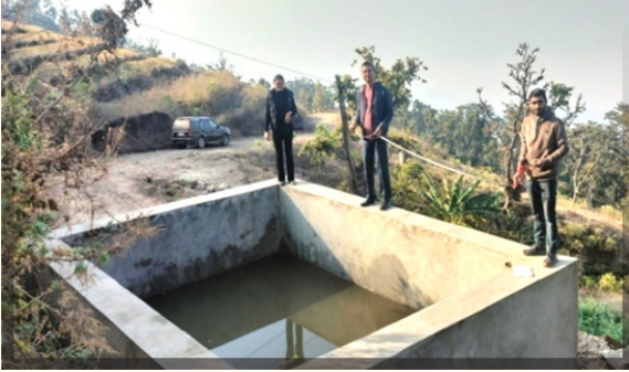
सिचाई पूर्वाधार निर्माण कार्यक्रम अन्तर्गत पोखरी निर्माण मालिका कृषक समुह पञ्चपुरी ४ चनालि
